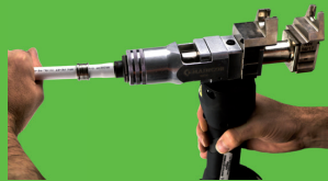
Hülse überschieben und Rohr aufweiten
